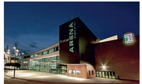
Veranstaltungsort: Die 1. MetallMesse Mittelhessen findet in der Rittal-Arena Wetzlar statt. Fotos: nh
