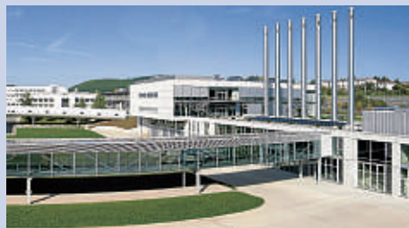
Die Energiezentrale ist räumlich direkt an die ebenfalls neu gebaute Akademie angeschlossen, die der Fortbildung der Viessmann Marktpartner sowie der eigenen Mitarbeiter dient.
